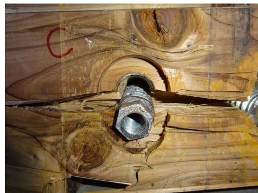
(o-6) CLT C解体時
