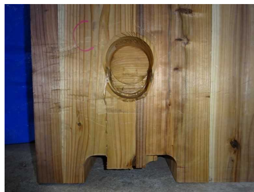
(a-6) CLT C解体時
