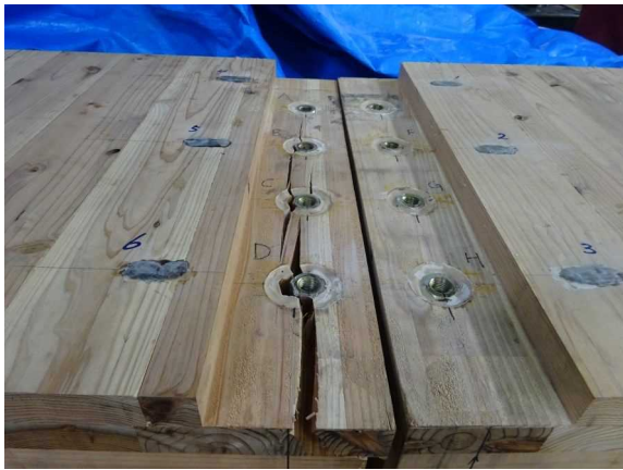
(b-3) 亀裂部分
