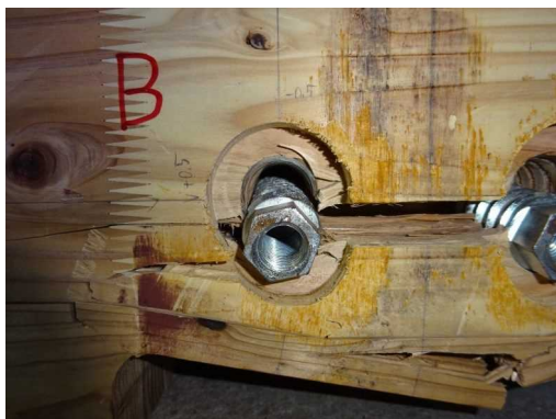
(o-7) CLT B解体時
