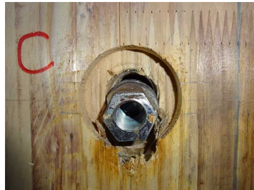
(1-6) CLT C解体時
