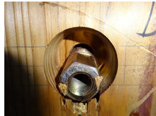
(e-8) CLT D解体時
