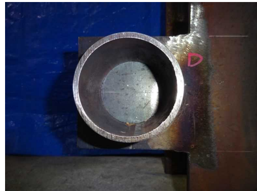
(b-20) H形鋼 D解体時
