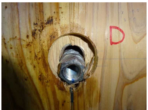
(n-8) CLT D解体時
