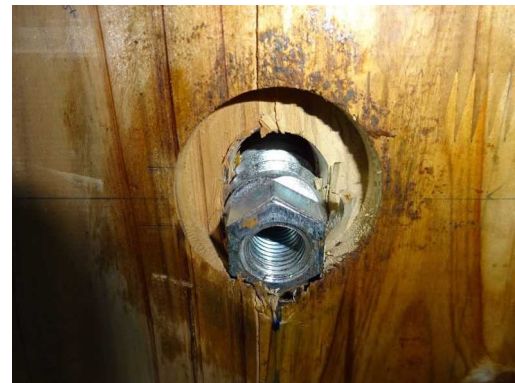
(n-6) CLT C解体時
