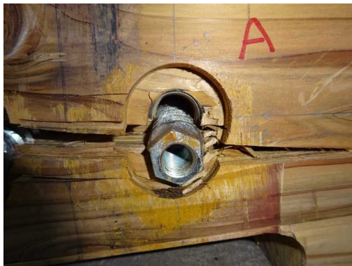
(o-5) CLT A解体時
