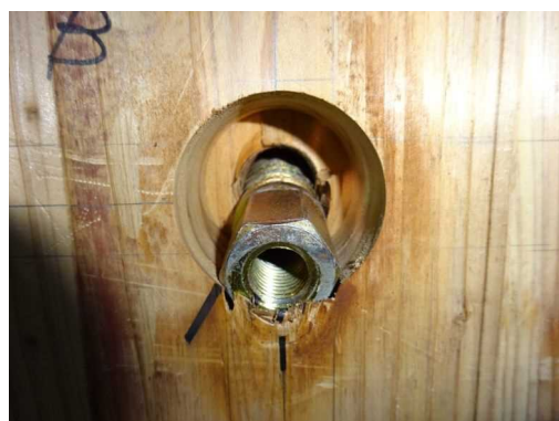
(c-7) CLT B解体時
