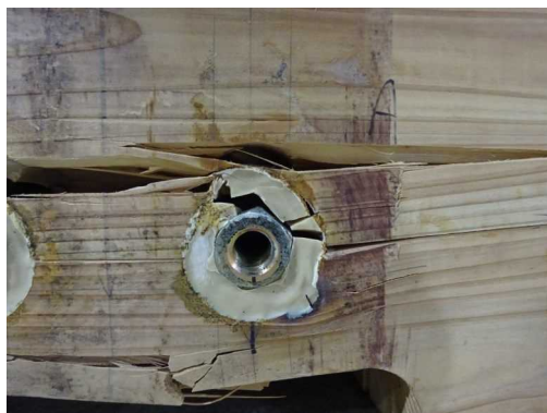
(j-5) CLT A解体時
