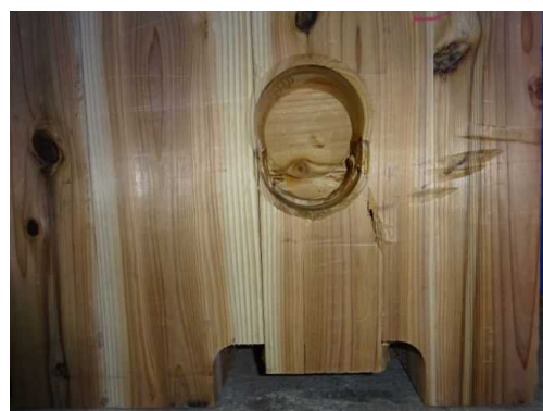
(a-8) CLT D解体時
