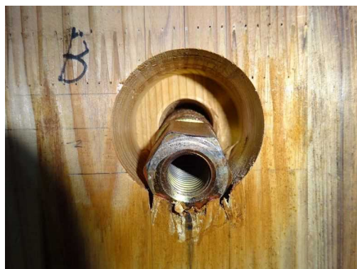
(a-7) CLT B解体時
