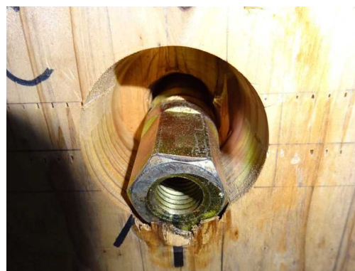
(c-6) CLT C解体時
