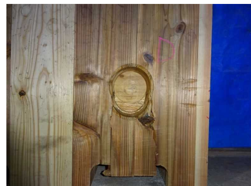
(b-8) CLT D解体時
