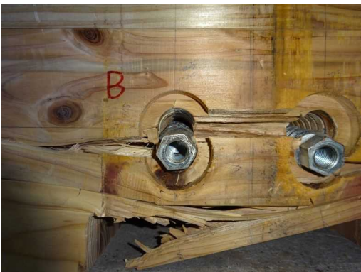
(p-7) CLT B解体時
