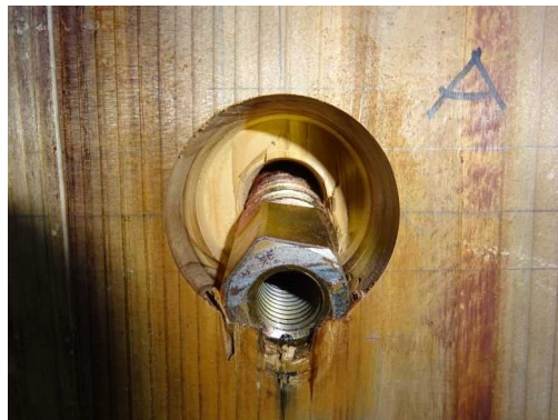
(a-5) CLT A解体時
