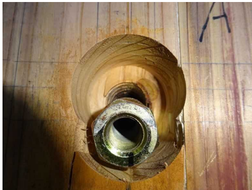
(g-5) CLT A解体時
