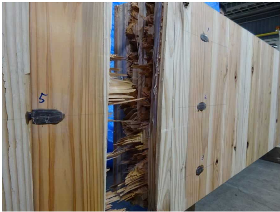
(a-3) 亀裂部分
