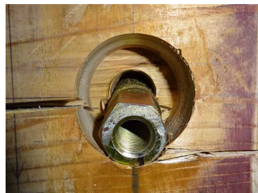
(h-8) CLT D解体時
