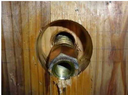
(f-5) CLT A解体時
