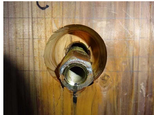
(f-6) CLT C解体時
