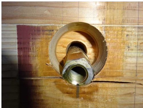
(i-7) CLT B解体時
