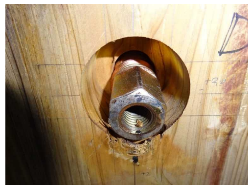
(a-8) CLT D解体時
