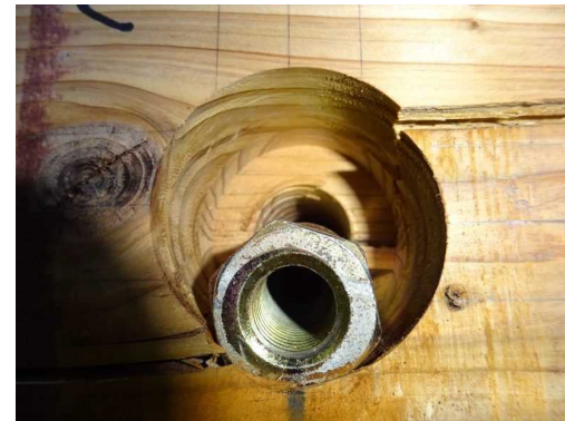
(h-6) CLT C解体時
