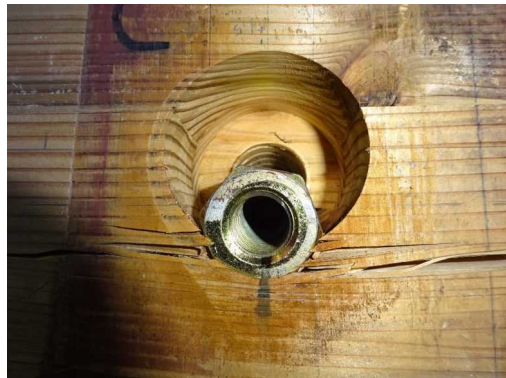
(i-6) CLT C解体時
