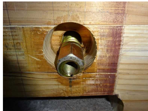
(i-8) CLT D解体時
