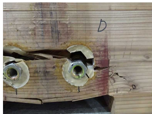
(k-8) CLT D解体時
