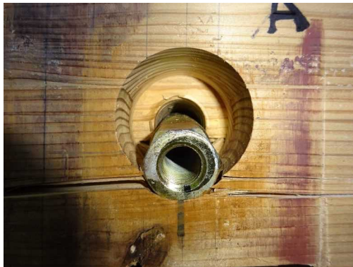
(i-5) CLT A解体時
