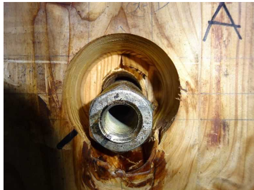
(b-5) CLT A解体時
