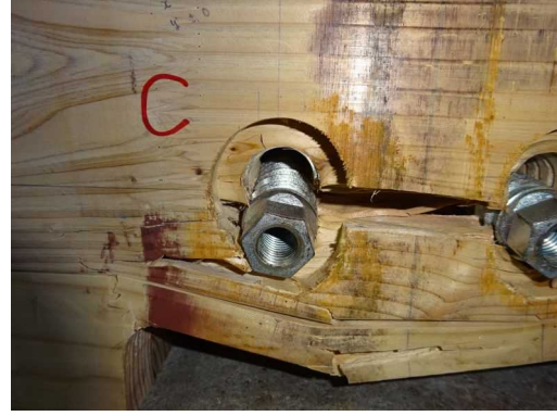
(p-6) CLT C解体時
