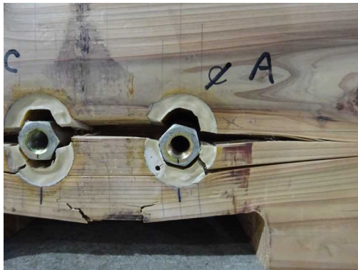
(k-5) CLT A解体時
