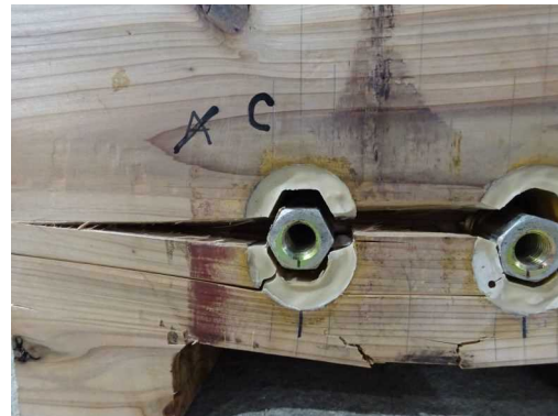
(k-6) CLT C解体時
