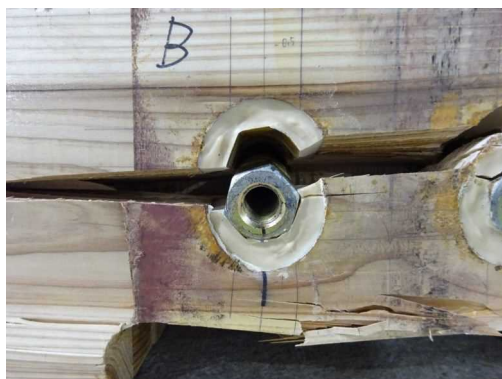
(j-7) CLT B解体時
