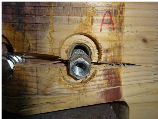
(p-5) CLT A解体時
