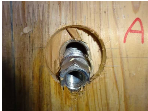
(1-5) CLT A解体時
