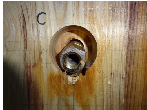
(a-6) CLT C解体時
