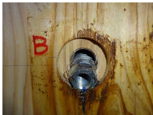
(n-7) CLT B解体時
