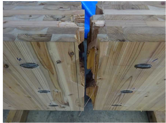
(c-4) 亀裂部分
