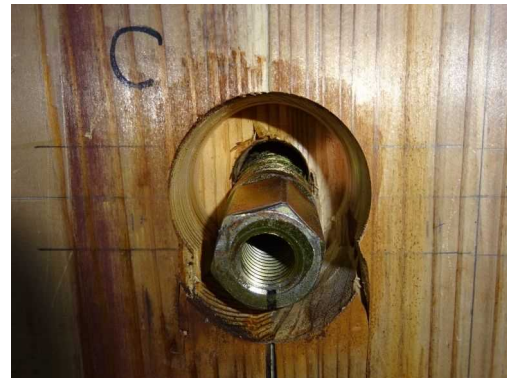
(g-6) CLT C解体時
