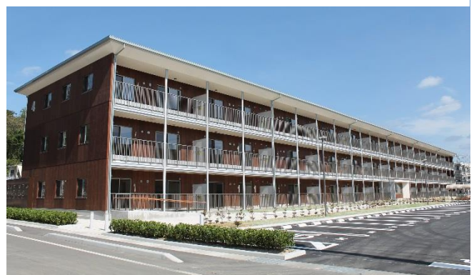
WOOD.ALCを採用した木質化事例 『復興公営住宅 石倉団地 (福島県二本松市)』
