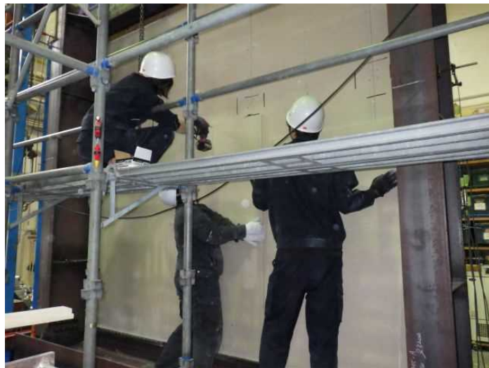
写真 3-2-7 施工風景（天井側）
