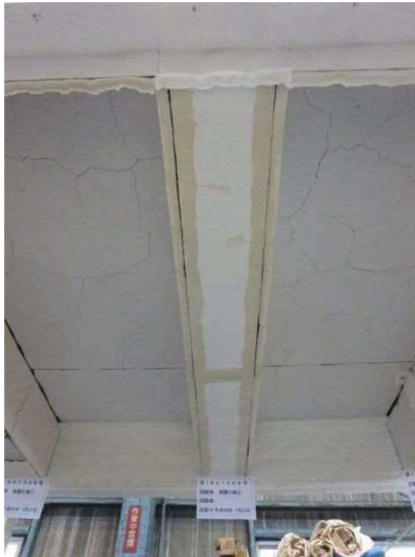
写真 25 試験後の試験体（加熱側）の状況（被覆仕様○）
