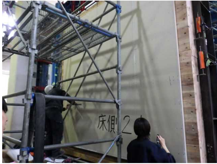
写真 3-2-6 施工風景（床側）
