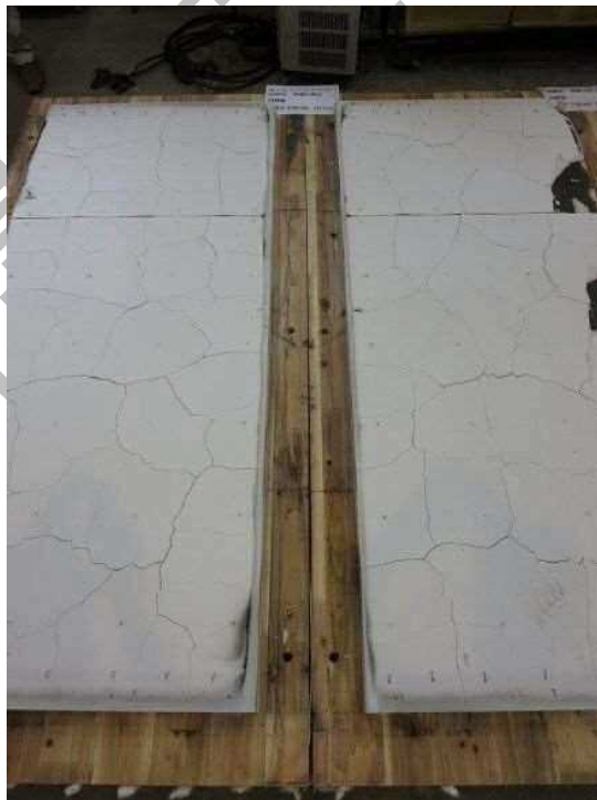
写真30 試験後のCLTパネルとはり接合部の状況（被覆仕様○）
