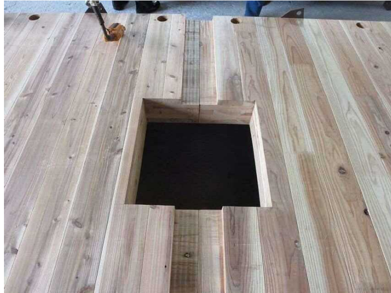
写真1 床側（裏面側）被覆材被覆前の CLT パネル開口部の状況
