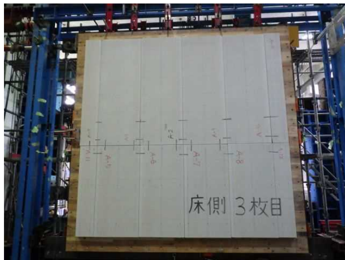
写真 3-2-10 床面 3 枚目・ALC 板施工写真
