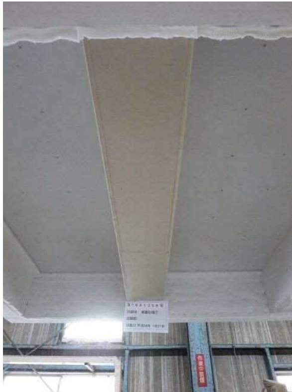
写真1 試験前の試験体（加熱側）の状況（被覆仕様○）
