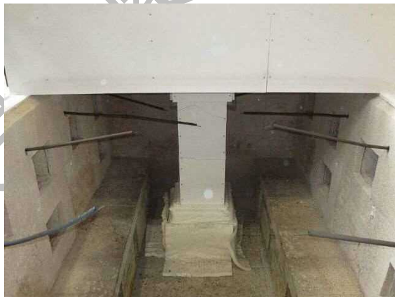
写真 15 試験後の試験体（加熱側）の状況
