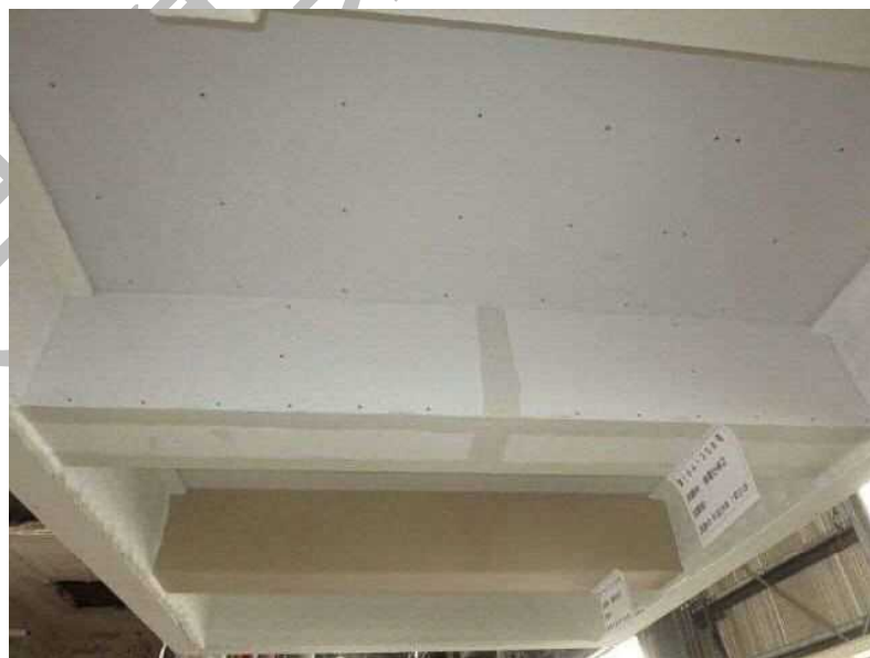
写真4 試験前の試験体（加熱側）の状況（被覆仕様◎）
