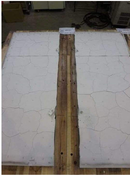
写真 31 試験後の CLT パネルとはり接合部の状況（被覆仕様◎）
