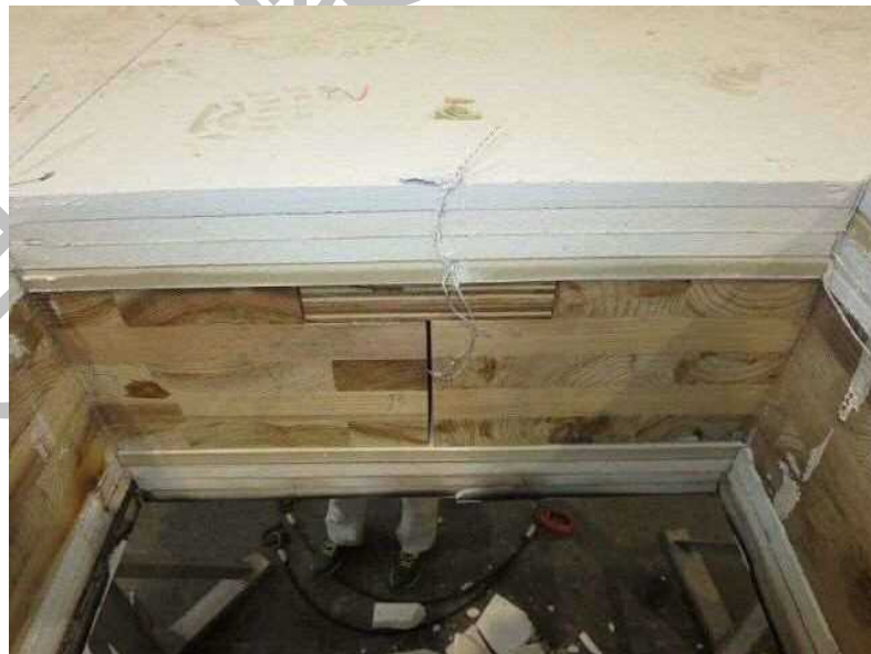
写真 20 試験後の試験体（開口部：北）の状況
