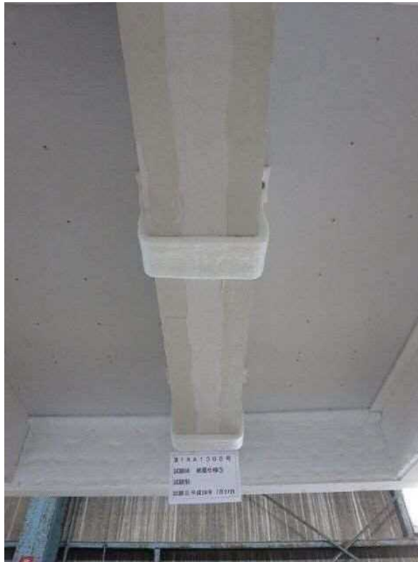
写真5 試験前の試験体（加熱側）の状況（被覆仕様◎）
