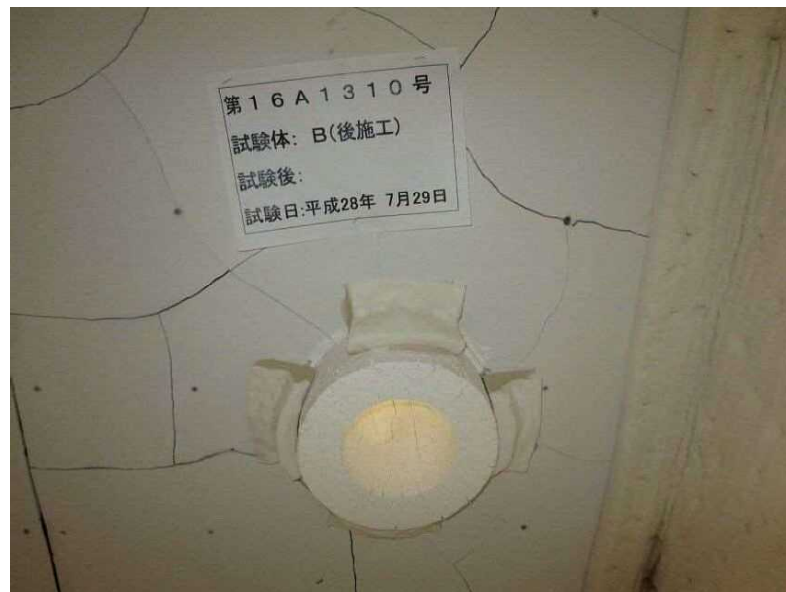
写真10 試験後の試験体（試験体B：加熱側）の状況
