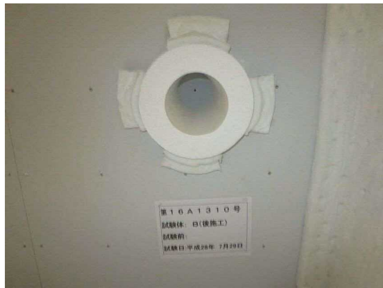
写真3 試験前の試験体（試験体B：加熱側）の状況
