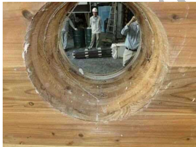
写真13 試験後の貫通孔（試験体B）の状況
