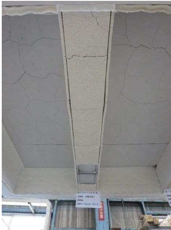
写真 23 試験後の試験体（加熱側）の状況（被覆仕様○）
