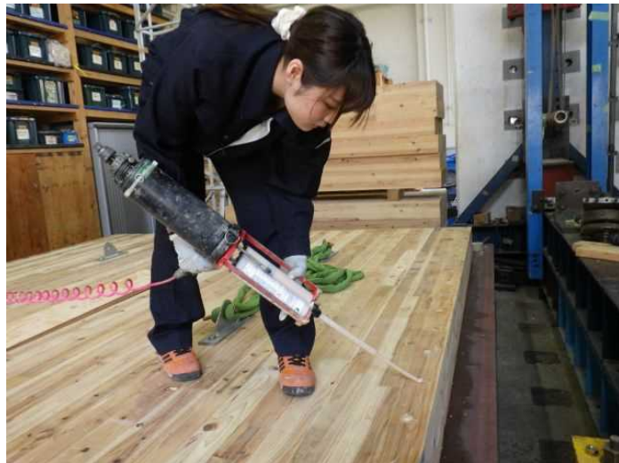
写真 3-2-2 施工風景（接着剤の注入）
