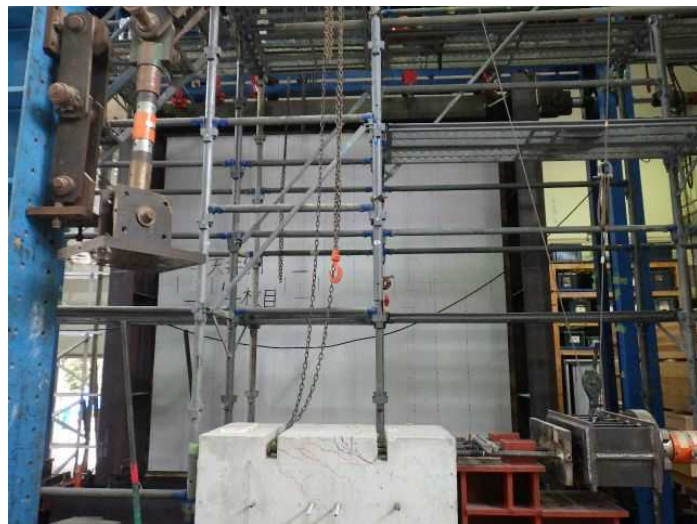
写真 3-2-14 天井面 4 枚目・ケイ酸カルシウム板施工写真
