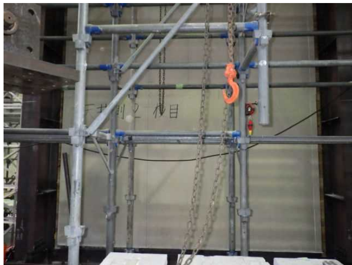
写真 3-2-12 天井面 2 枚目・強化石膏ボード施工写真
