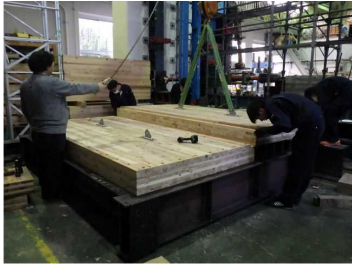
写真 3-2-1 施工風景（スタッド位置合わせ）
