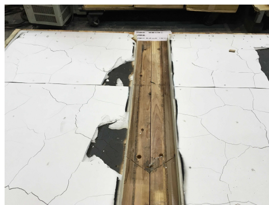
写真 4-4 被覆仕様① 試験後 CLT 表面
