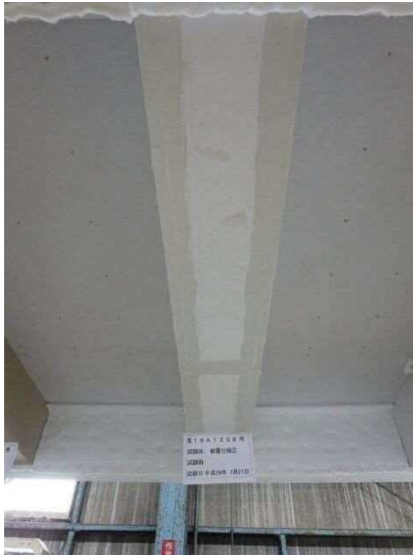
写真3 試験前の試験体（加熱側）の状況（被覆仕様◎）
