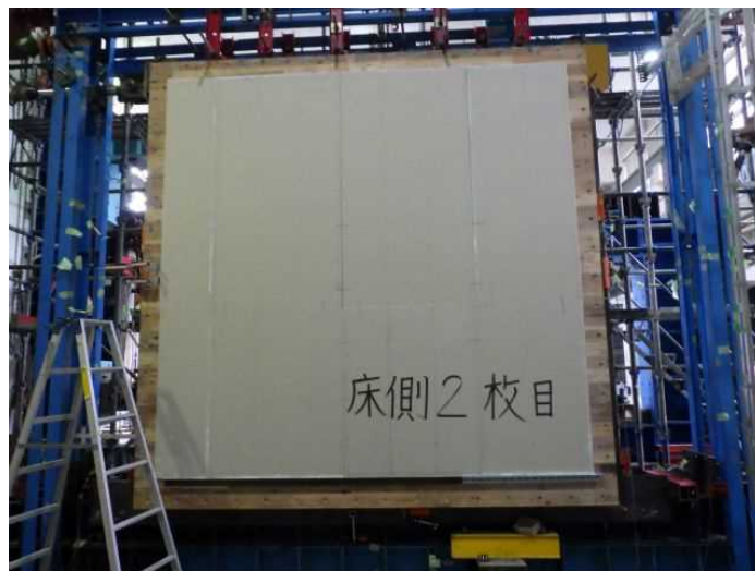
写真 3-2-9 床面 2 枚目・強化石膏ボード施工写真
