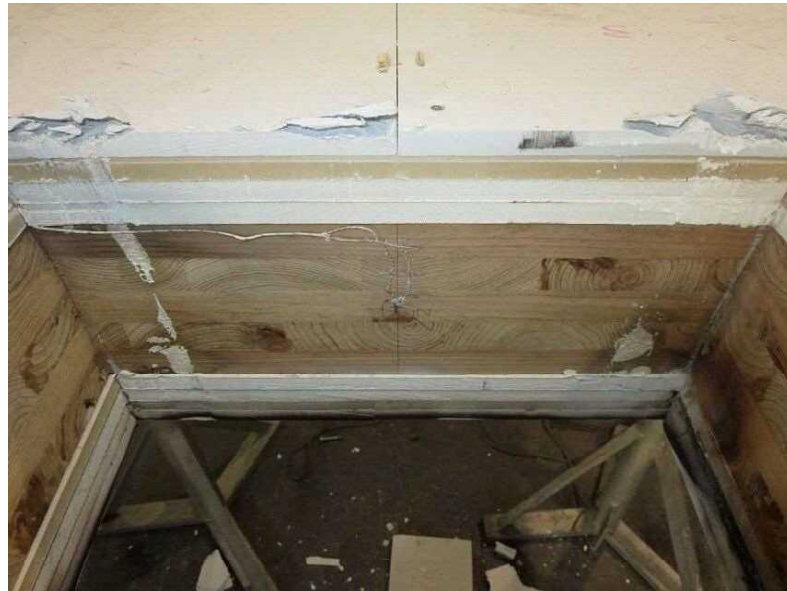
写真21 試験後の試験体（開口部：東）の状況
