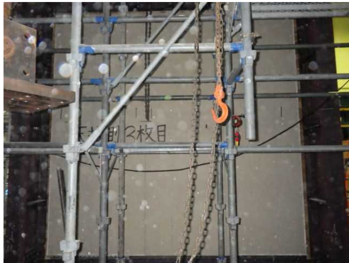
写真 3-2-13 天井面 3 枚目・強化石膏ボード施工写真
