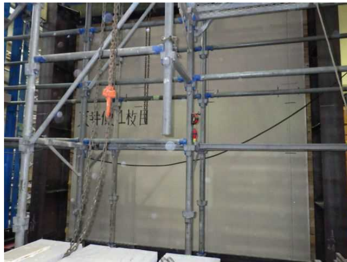
写真 3-2-11 天井面 1 枚目・強化石膏ボード施工写真
