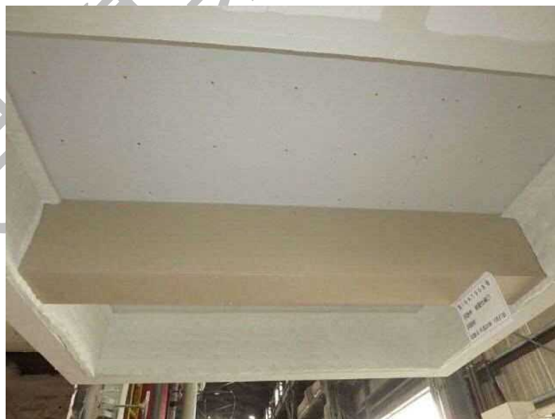
写真2 試験前の試験体（加熱側）の状況（被覆仕様○）
