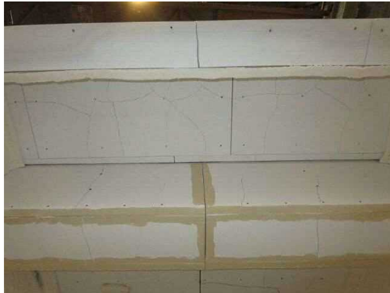
写真15 試験後の試験体（床取合い部：加熱側）の状況
