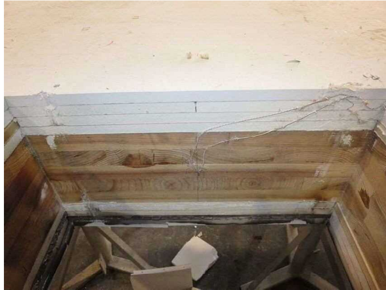
写真 19 試験後の試験体（開口部：西）の状況
