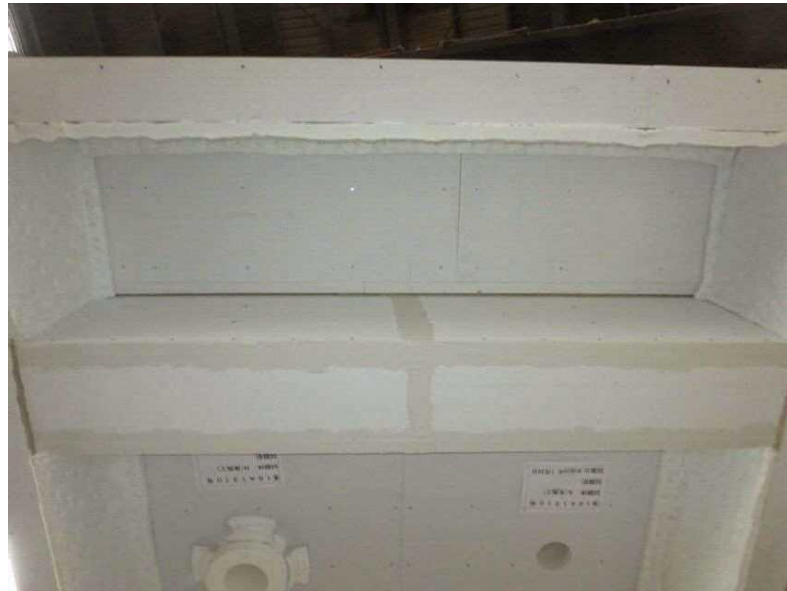
写真5 試験前の試験体（床取合い部：加熱側）の状況
