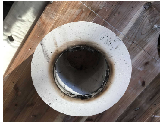
写真 2-4 後施工タイプ
