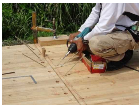
(a) 打ち込みの様子
