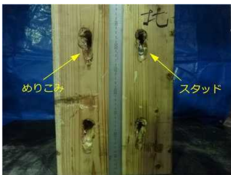
(c) 解体後（木側）
