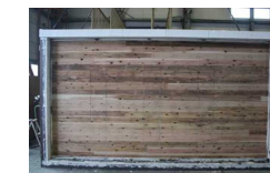
↑加熱試験後状況
