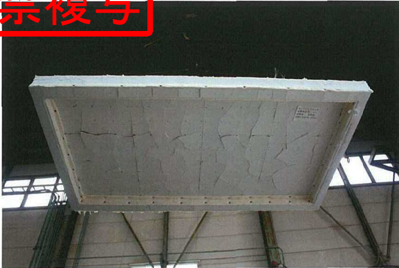
写真-4 試験後の加熱側（天井側） の状況（試験体記号A1）
