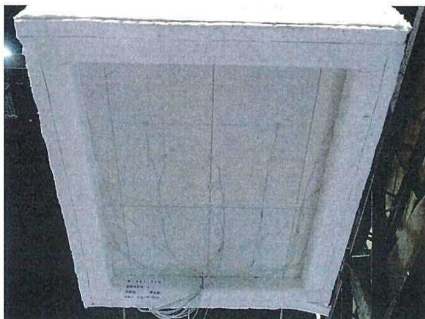
写真-4 試験後の裏面側（天井側）の状況（試験体記号A）
