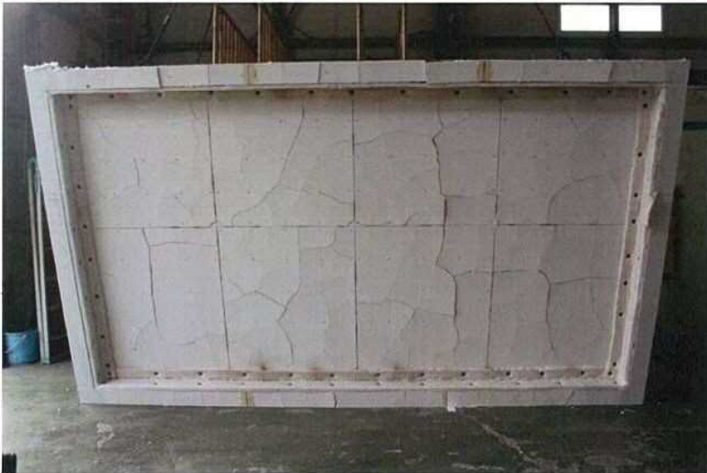
写真-5 試験後の加熱側（天井側） けい酸カルシウム板表面 の状況（試験体記号A）
