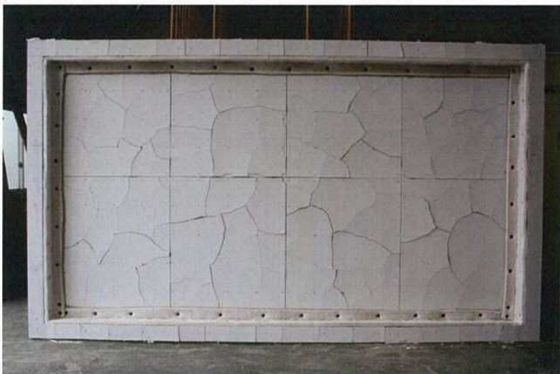
写真-5 試験後の加熱側（天井側） けい酸カルシウム板表面 の状況（試験体記号B）
