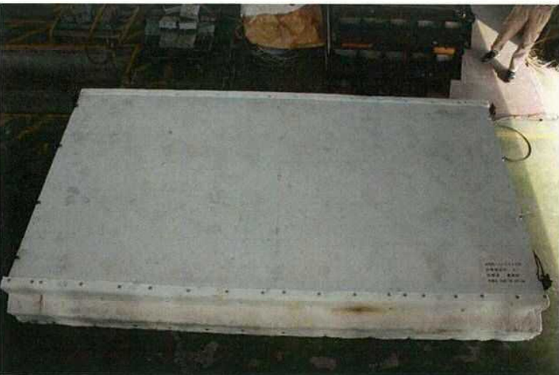
写真-3 試験後の裏面側（床側） の状況（試験体記号A）
