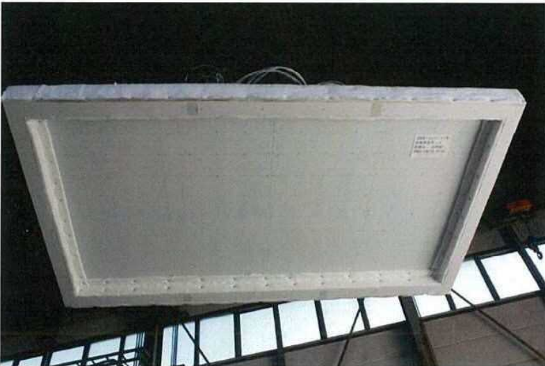
写真-2 試験前の加熱側（天井側） の状況（試験体記号A）
