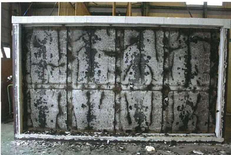
写真-6 試験後の加熱側（天井側） 上張強化せっこうボード 表面の状況 （試験体記号A1）
