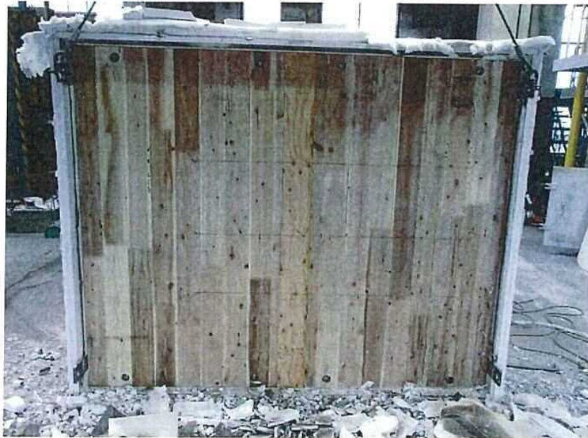
写真-7 試験後のCLTパネル 表面の状況（床側）（試験体記号A）
