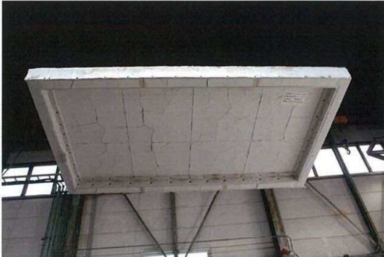
写真-4 試験後の加熱側（天井側） の状況（試験体記号A）
