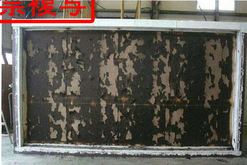
写真-7 試験後の加熱側（天井側） 中張強化せっこうボード 表面の状況 （試験体記号A1）
