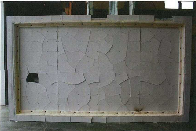
写真-14 試験後の加熱側（天井側） けい酸カルシウム板表面 の状況 （試験体記号A2）
