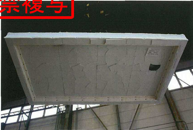
写真-13 試験後の加熱側（天井側） の状況（試験体記号A2）
