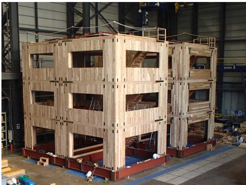
平成 27 年度 D 棟及び E 棟全景 (実験準備棟にて施工中)
