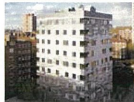
Stadthaus 9階建て分譲マンション。床・壁・エレベーターシャフトにCLTが使われています。(イギリス, 2009)
