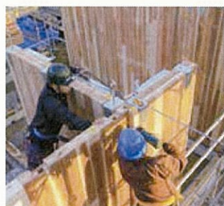
水平方向に壁パネルどうしは雇いざねを介して接合。
