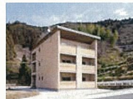
おとよ製材社員寮 製材所の3階建て社員寮。国土交通大臣認定を取得して建てられました。(高知県大豊町, 2014)
