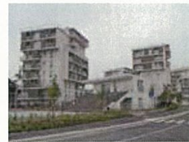
Via Cenni 9階建ての公営集合住宅。全ての階の壁・床・天井にCLTが利用されています。(イタリア, 2013)
