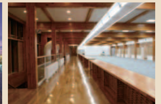
足寄町役場庁舎(北海道)燃えしろ設計による建築例
