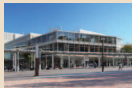
サウスウッド(神奈川県) 構造材に耐火集成材を現して使用した大規模商業施設の例
